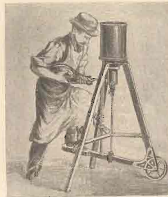
16. sz. ábra. Gaveuse-féle tömőgép.
